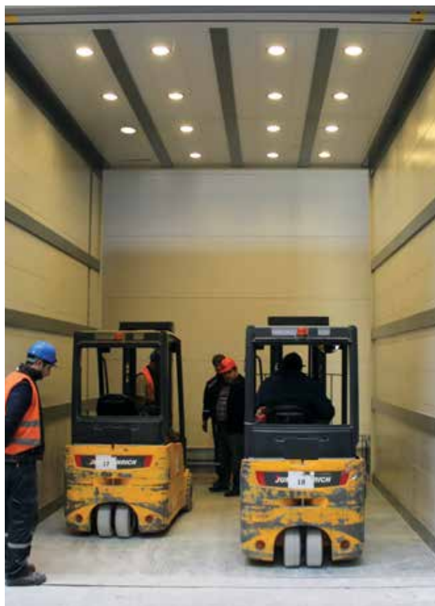
Hydraulic lift (rated load 10.000 kg) Hydraulikaufzug (Nutzlast 10.000Kg)
